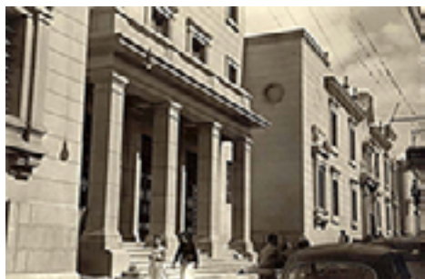
Fachada actual del Edificio Central de la Universidad de Los Andes Fuente: Archivo Histórico de la Universidad de Los Andes
