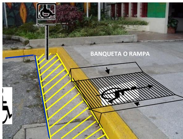
Las Rampas o Banquetas deben tener una pendiente máxima del 8%, pavimento antiderrapantes, libre de obstáculos y un ancho mínimo de 1,20 mts, con cambio de textura en el pavimento y señalización de las rampas. Para la Señalización existe un símbolo internacional cuyas medidas y proporciones adecuadas aparecen en las Normas Venezolanas y Recomendaciones de Accesibilidad.
