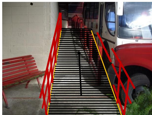
**Nota:** La Longitud máxima de las rampas entre descansos será de 6 m y los descansos tendrán una longitud mínima igual al ancho de la rampa y nunca menor de 1,20 mts.
