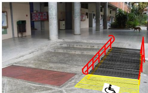
**Nota:** Las áreas de aproximación inicial y final de la rampa deben estar libres de obstáculos, con cambio de textura de piso, el piso de la rampa debe tener un acabado antiderrapante, con pasamanos a 0,75 y 0.90 mts de altura y un borde de protección en ambos lados de 5 por 5 cms.
