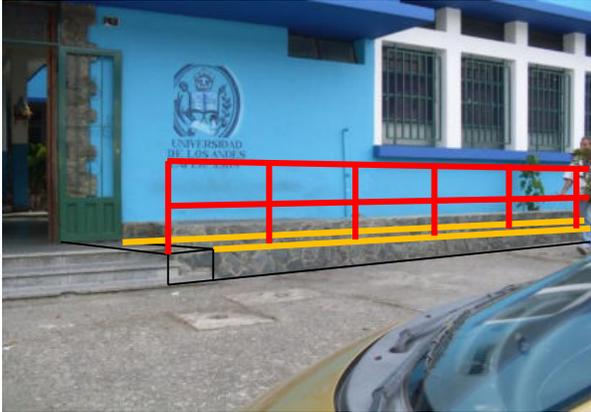
**Nota:** Las áreas de aproximación inicial y final de la rampa deben estar libres de obstáculos, con cambio de textura de piso, el piso de la rampa debe tener un acabado antiderrapante, con pasamanos a 0,75 y 0.90 mts de altura y un borde de protección en ambos lados de 5 por 5 cms.
