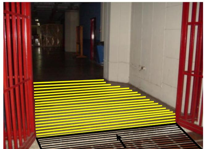
**Nota:** Las áreas de aproximación a los accesos y pasillos de las edificaciones deben estar libres de obstáculos, con cambio de textura de piso, para que el discapacitado visual, pueda identificar rápidamente las entradas y salidas.
